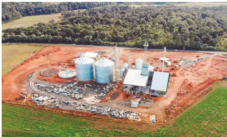
Obras da estrutura em Papanduva
